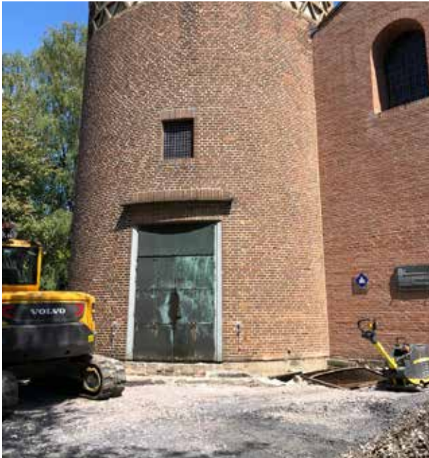
Aktuell kein Zutritt möglich durch die Bauarbeiten am Verwaltungsgebäude der Kirchenkreise auf dem Kirchenvorplatz.
